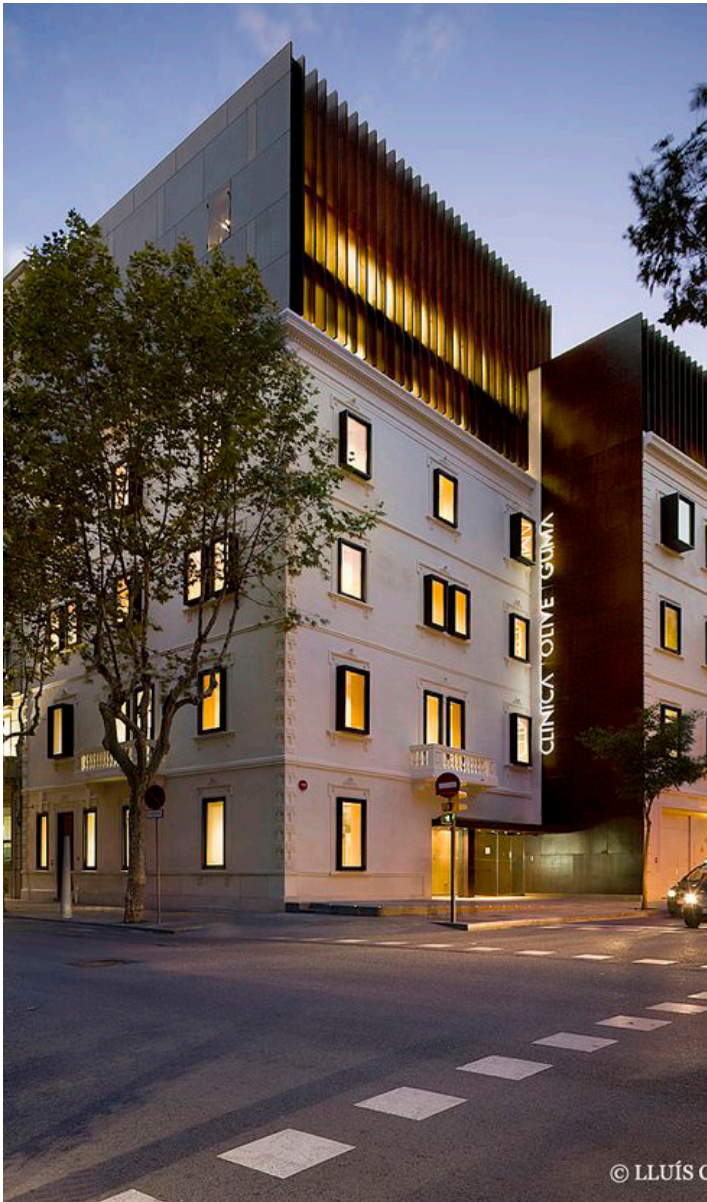
New Olivé Gumà Clinic / Octavio Mestre Arquitectos / Barcelona, Spain
